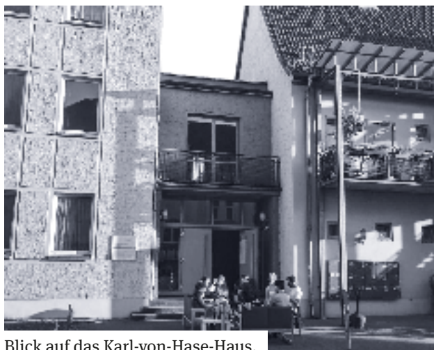
Blick auf das Karl-von-Hase-Haus.
